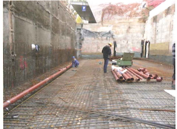
Pose de la canalisation d'assainissement au niveau du radier
