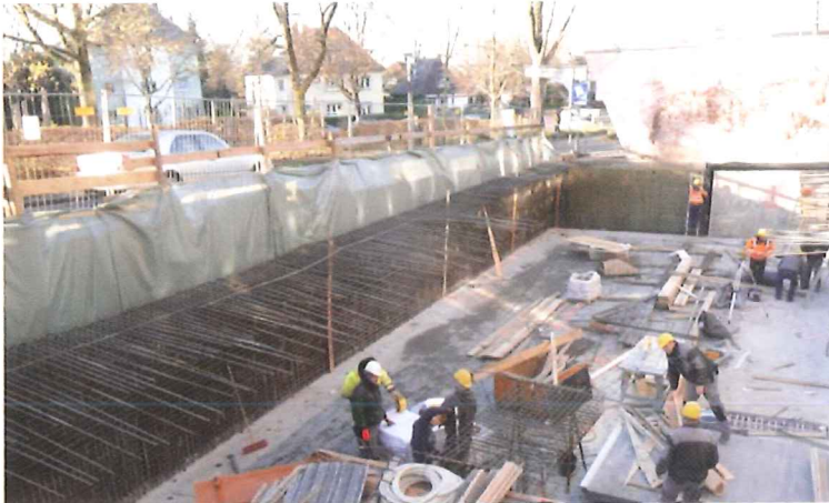
Travaux au niveau du plancher intermédiaire
