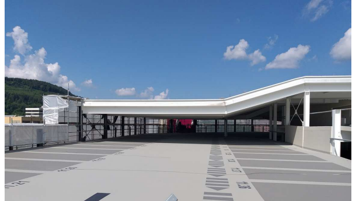
Terrasse après réhabilitation (Photo: Kerstin Götz)
