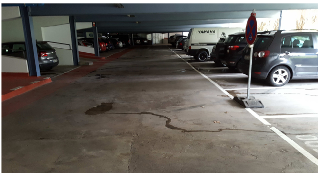
Voie de circulation avant la réhabilitation (Photo: AMP)
