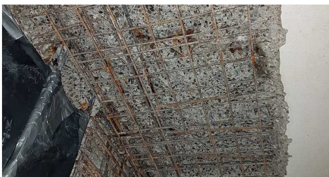
Exemple de réhabilitation (Photo: AMP)
