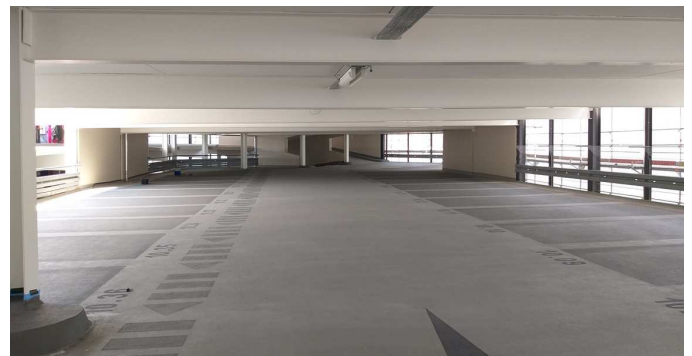
Voie de circulation après la réhabilitation (Photo: Kerstin Götz)
