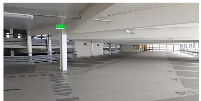
Voie de circulation après la réhabilitation (Photo: AMP)
