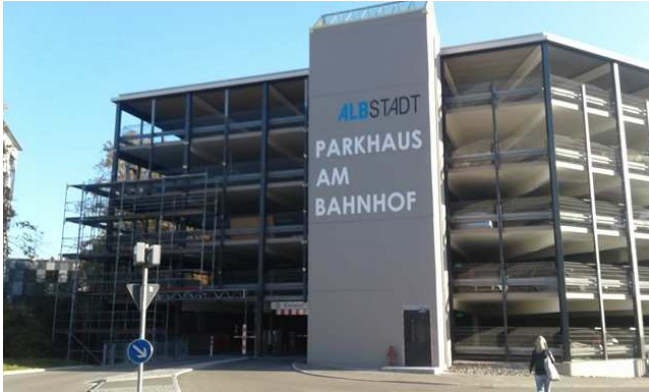
Façade Ouest avec nouveaux accès et sortie (Photo: Kerstin Götz)
