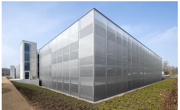
Vue Nord-Ouest de la Façade de l'escalier (Photo: Haver & Boecker)
