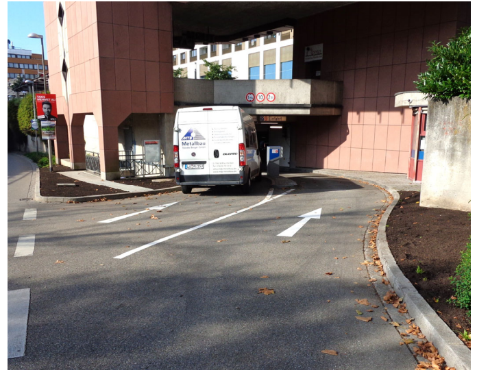
Accès au Parking souterrain (Image: AMP)
