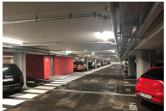
Voie du Parking après réhabilitation (Image: AMP)
