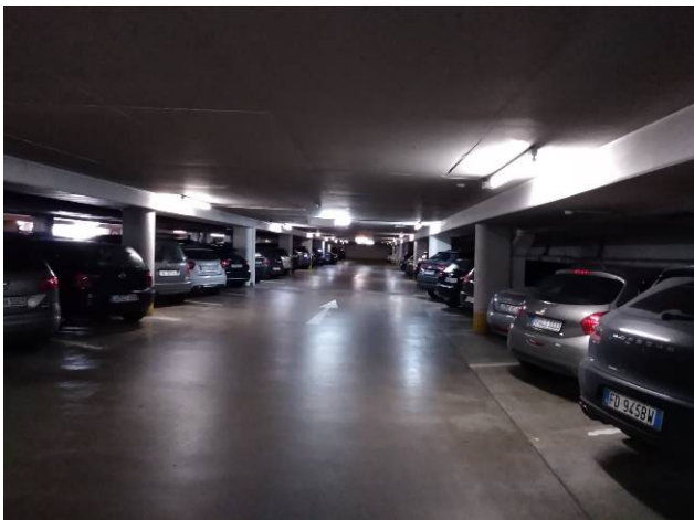
Voie du Parking avant réhabilitation (Image: AMP)
