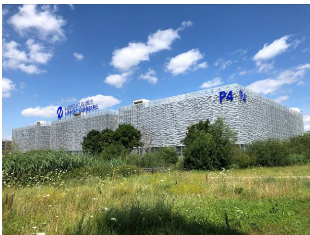
Vue du Sud-Ouest (Image: AMP)
