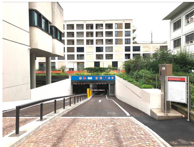
Einfahrt zur Tiefgarage (Foto: AMP)
