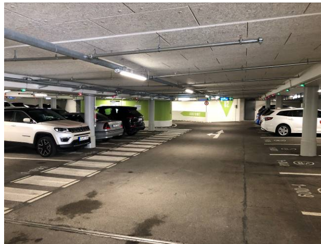
Parkgasse nach der Instandsetzung (Foto: AMP)
