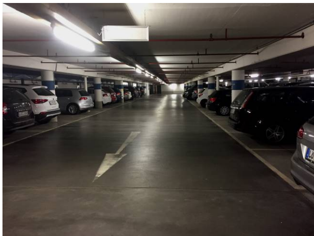
Parkgasse vor der Instandsetzung (Foto: AMP)
