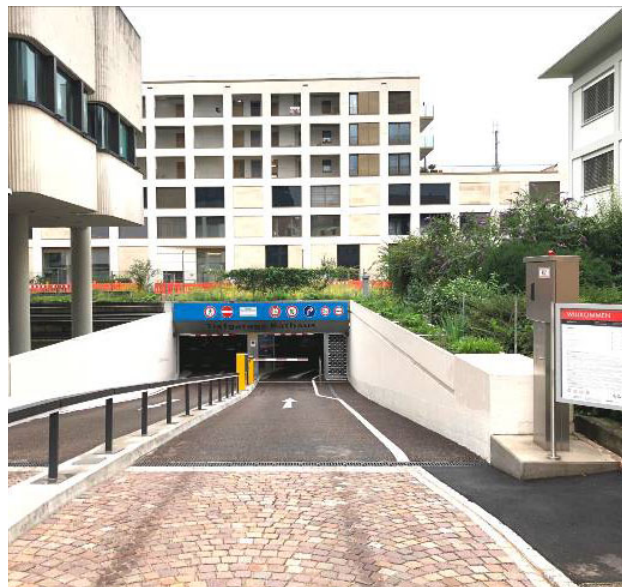
Accès au Parking souterrain (Image: AMP)
