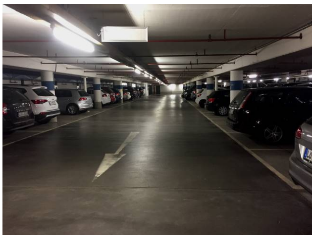
Voie du Parking avant réhabilitation (Image: AMP)
